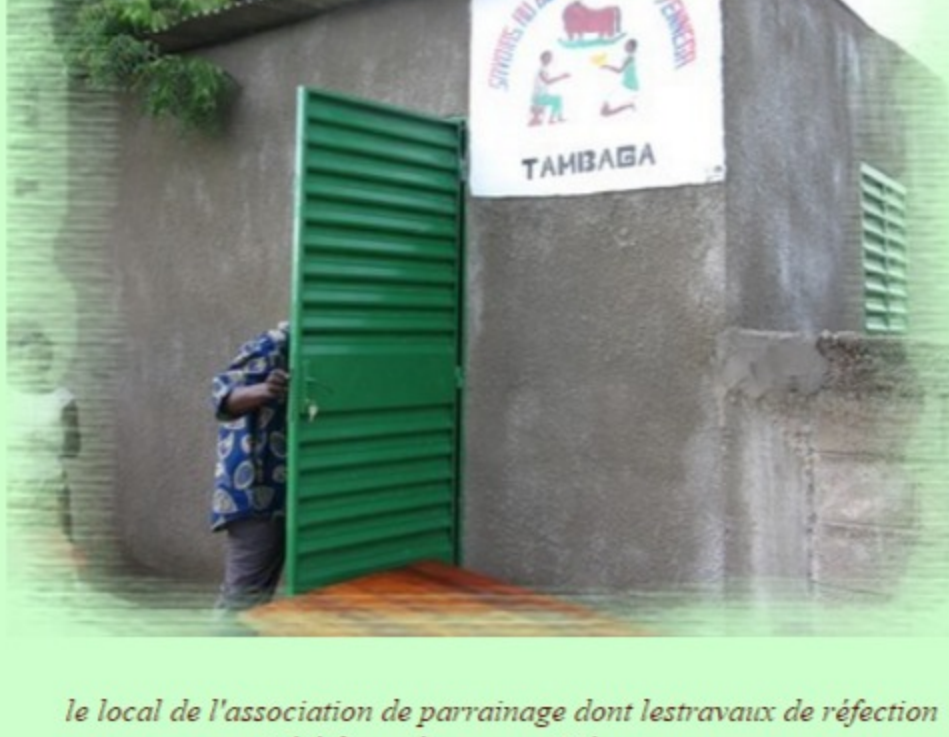
le local de l'association de parrainage dont lestravaux de réfection ont été financés pour moitié par yemega
